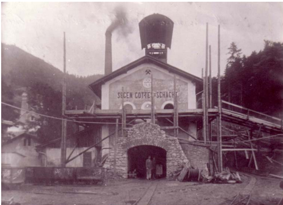
Der Segen Gottes – Schacht
