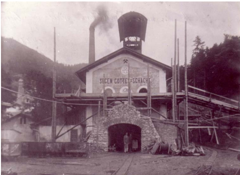
„Der Segen Gottes – Schacht“
